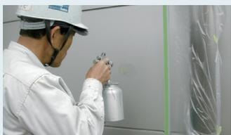
パテ処理後、吹き付け作業です。タッチアップの跡が残らないよう、塗料を限界まで希釈し少しずつ何度かに分けて色を吹き付けていきます。
