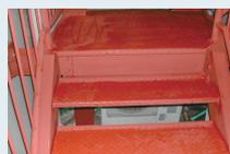
下塗り（錆止め）に入ります。錆止め塗料はエポキシ系の物を使用し、刷毛とローラーで塗り残しがないよう全面塗装します。
