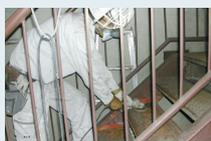
高圧洗浄機で外側と内側から水洗いし、埃を洗い流します。塗り替え作業で最も大事なケレン作業。被塗装物に付いている旧塗膜と錆をディスクサンダーを使用して除去。徹底的にしないと長持ちしません。
