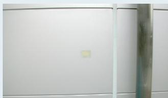
作業時間も限られていたため、打ち合わせの結果、パテ処理後、タッチアップ吹きという判断になりました。へこみ部分がフラットになるまで「パテ→磨き」を繰り返します。
