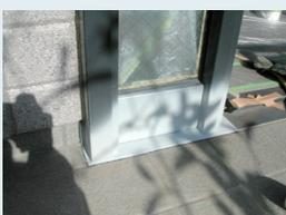
周囲をマスキング後、防錆効果の高いエポキシ樹脂で下塗り。錆びが多量に発生していたので入念に下地処理します。
